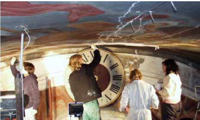
Slika 1 Stolnica sv. Nikolaja: restavratorski poseg na stropu (foto: arhiv ZVKDS RC)
