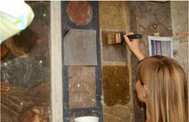
Slika 3 Cerkev Marijinega oznanjenja: nanašanje in ugotavljanje ustreznosti različnih utrjevalcev, kapela sv. Treh kraljev (foto: arhiv ZVKDS RC)
